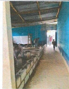
Foto 4: Levantamiento de pared de division y cernillado.
