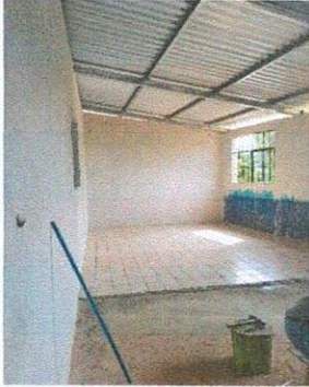
Foto 1: Colocación de Techo
