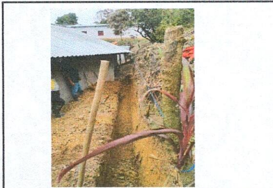
Foto 9: Muro de contención o perimetral. 3 y 22 mts.
