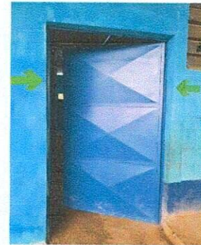
Foto 6: Colocación de puerta (b)
