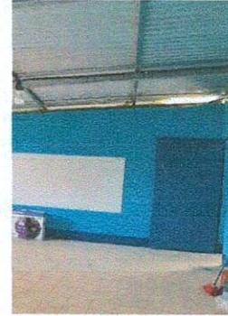
Foto 2: Colocación de puerta (a)
