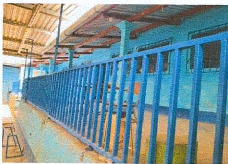
Foto 5: Levantamiento de muro de seguridad metálico.
