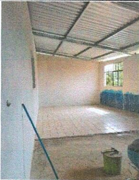
Foto 3: Colocación de piso.
